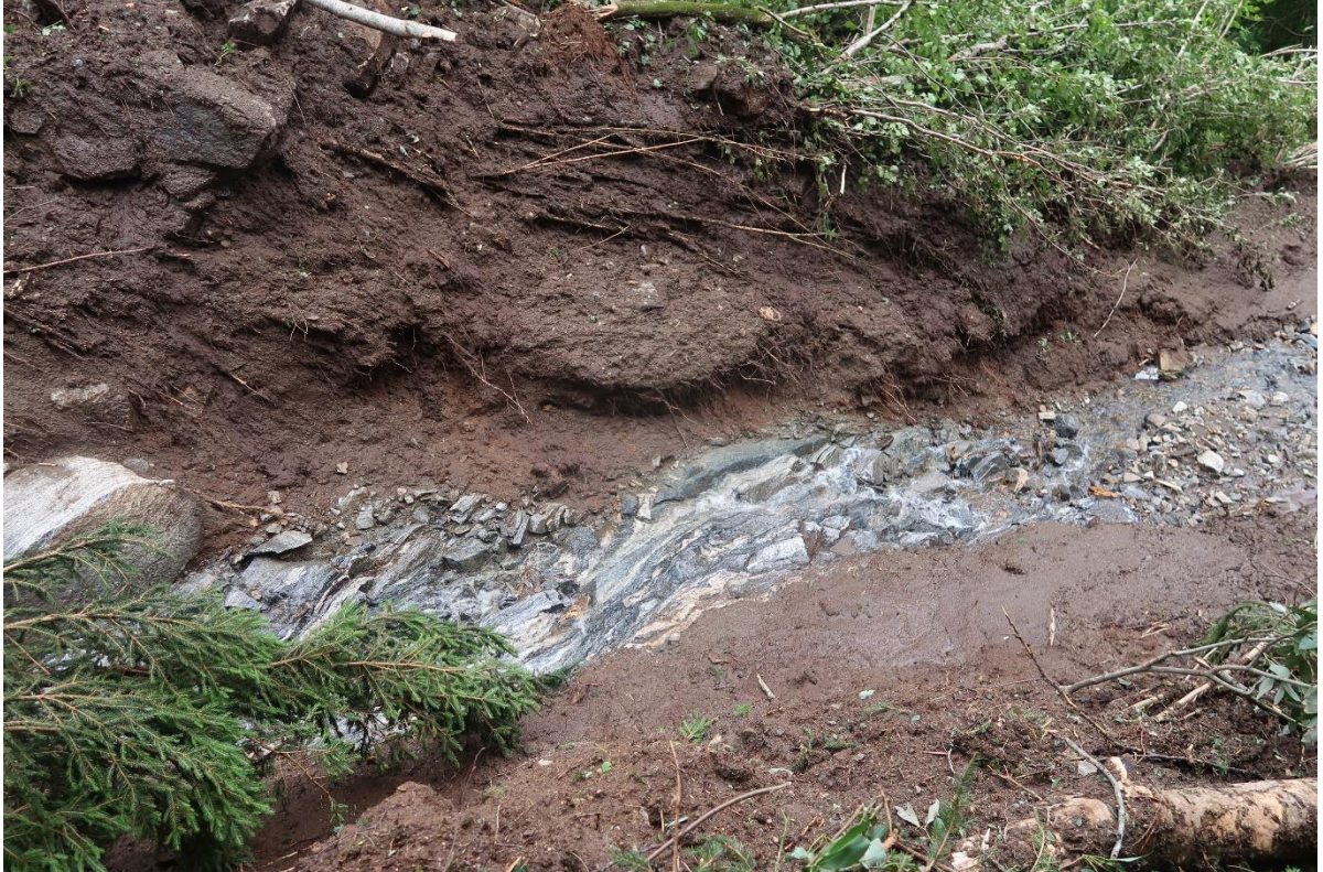
Figur 15. Tykke jordmasser langs kanten av skredløpet for skred 3 ca. 150-170 moh. Selve bekkeløpet er erodert til glatt berg.
