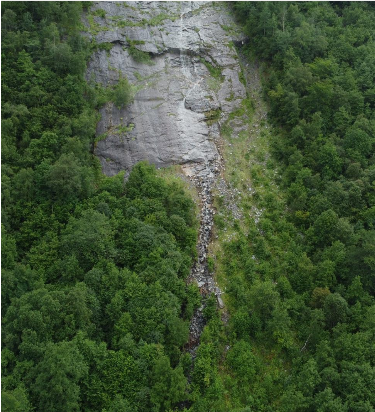
Figur 25. Et av løsneområdene der stein og jordmasser i ur under berget sannsynligvis er aktivert av store vannmengder.
