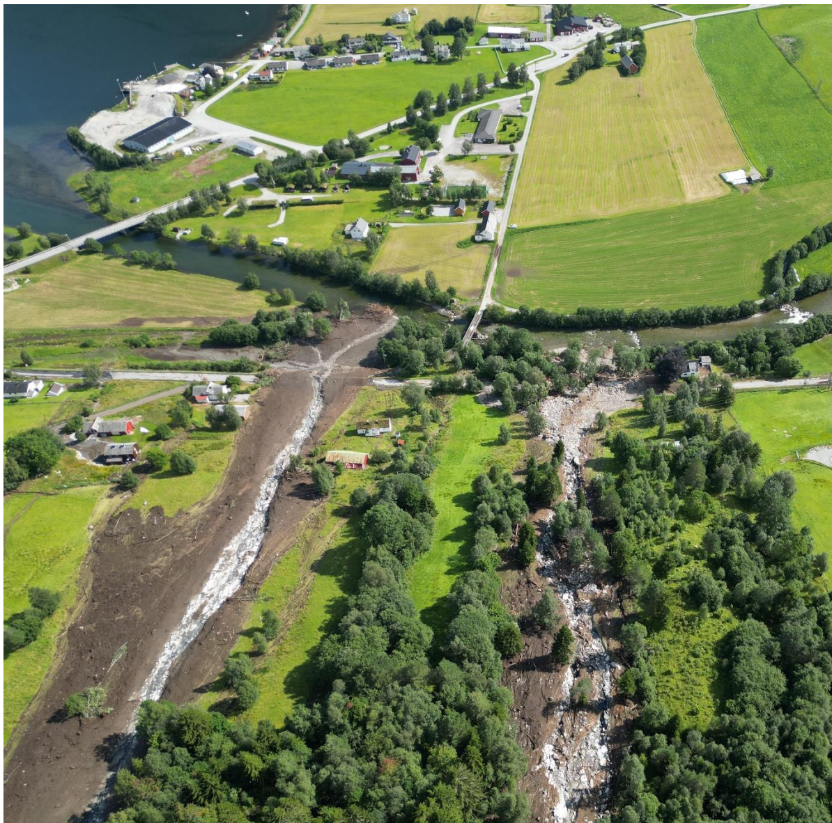
Figur 11. Dronebilde som viser nedre del av skred 1 (venstre) og skred 2 (høyre). Skred 1 er dominert av finere jordmasser, mens skred 2 har grove stein og blokk. Skred 2 har ført til ødeleggelser av bygninger og vei.
