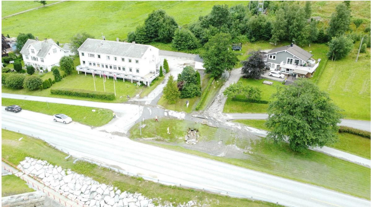
Figur 22. Eidsvåg fjordhotell og grått bolighus til høyre (nr. 118). Stikkrenne mellom bygningene har mest sannsynlig gått tett, og vannmasser har flommet mot hotell og ødelagt oppkjørsel til nr. 118.
