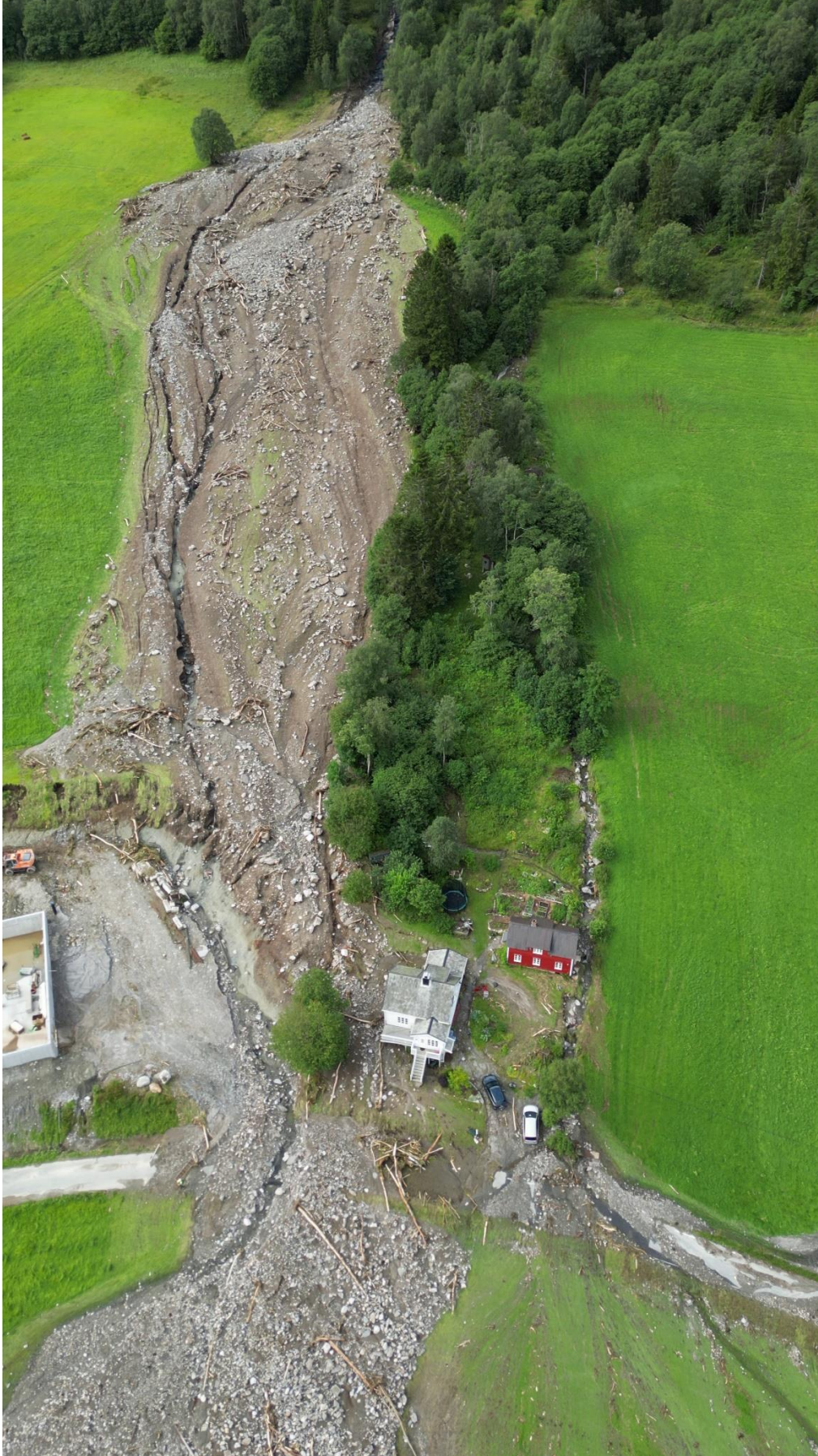
Figur 19. Skred 4 ved Langnesvegen 81. Skredmasser har etablert nye vannveier over jordet til venstre, den opprinnelige bekken kommer ned på høyre side av det røde huset.
