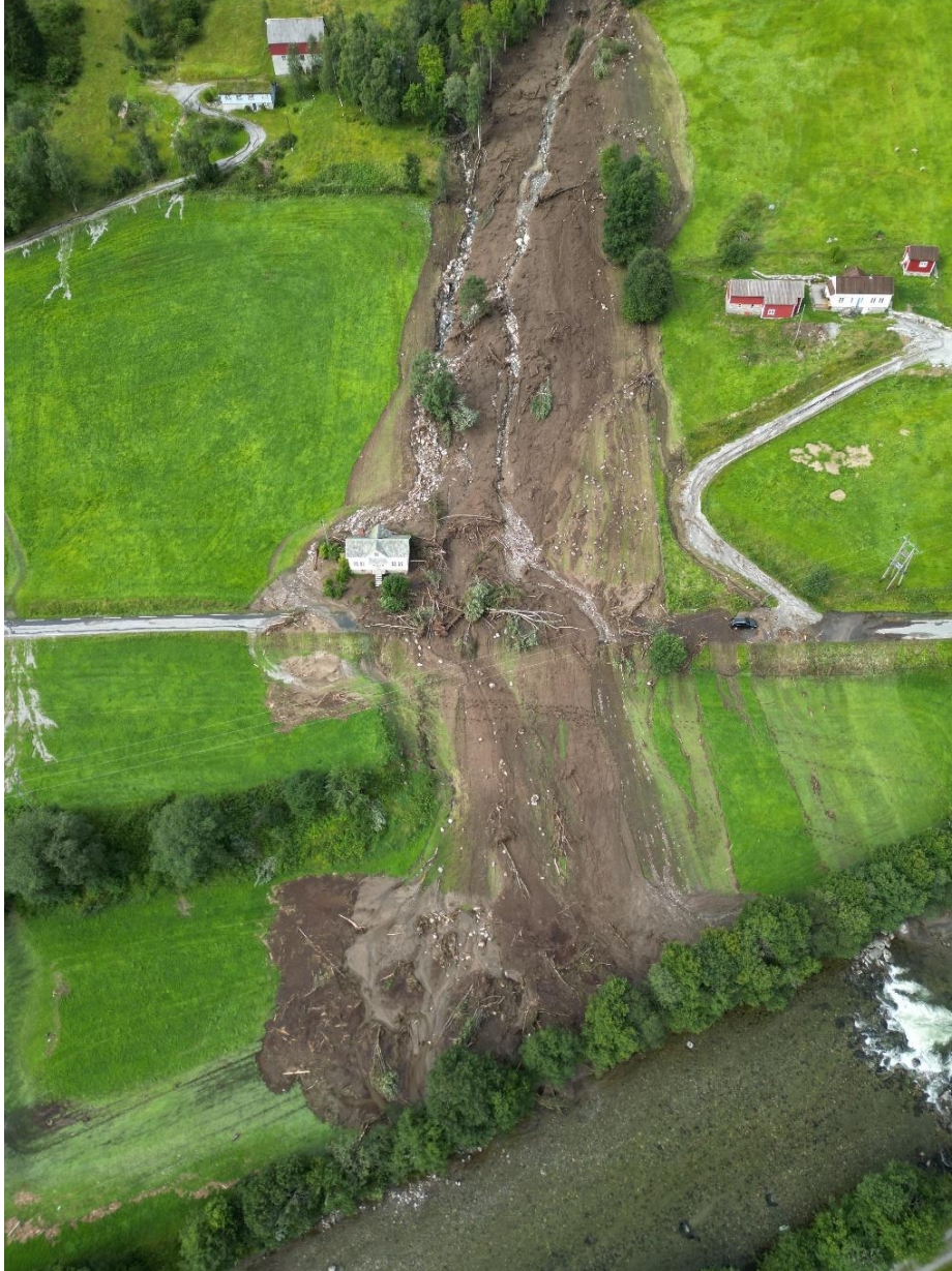
Figur 14. Skred 3 ved Langevegen 61, sett mot vest. Det er mest steinmasser langs det sørlige bekkeløpet (venstre), og mer jord langs det nordlige løpet (høyre).
