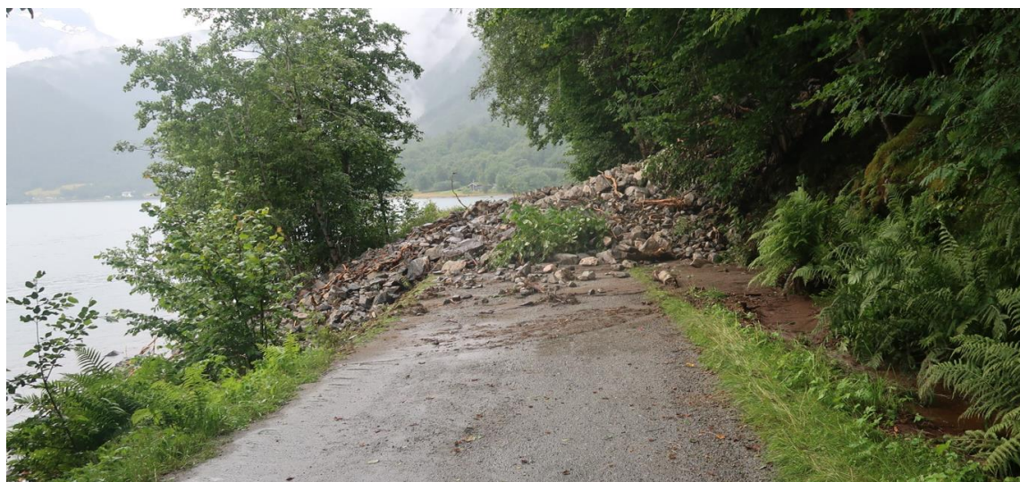
Figur 24. Et av skredpunktene der skredmasser blokkerer Meringsdalsvegen.
